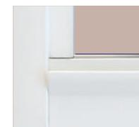
Assemblage en coupe droite à 90 ° (coulissant construction 2 rails).
